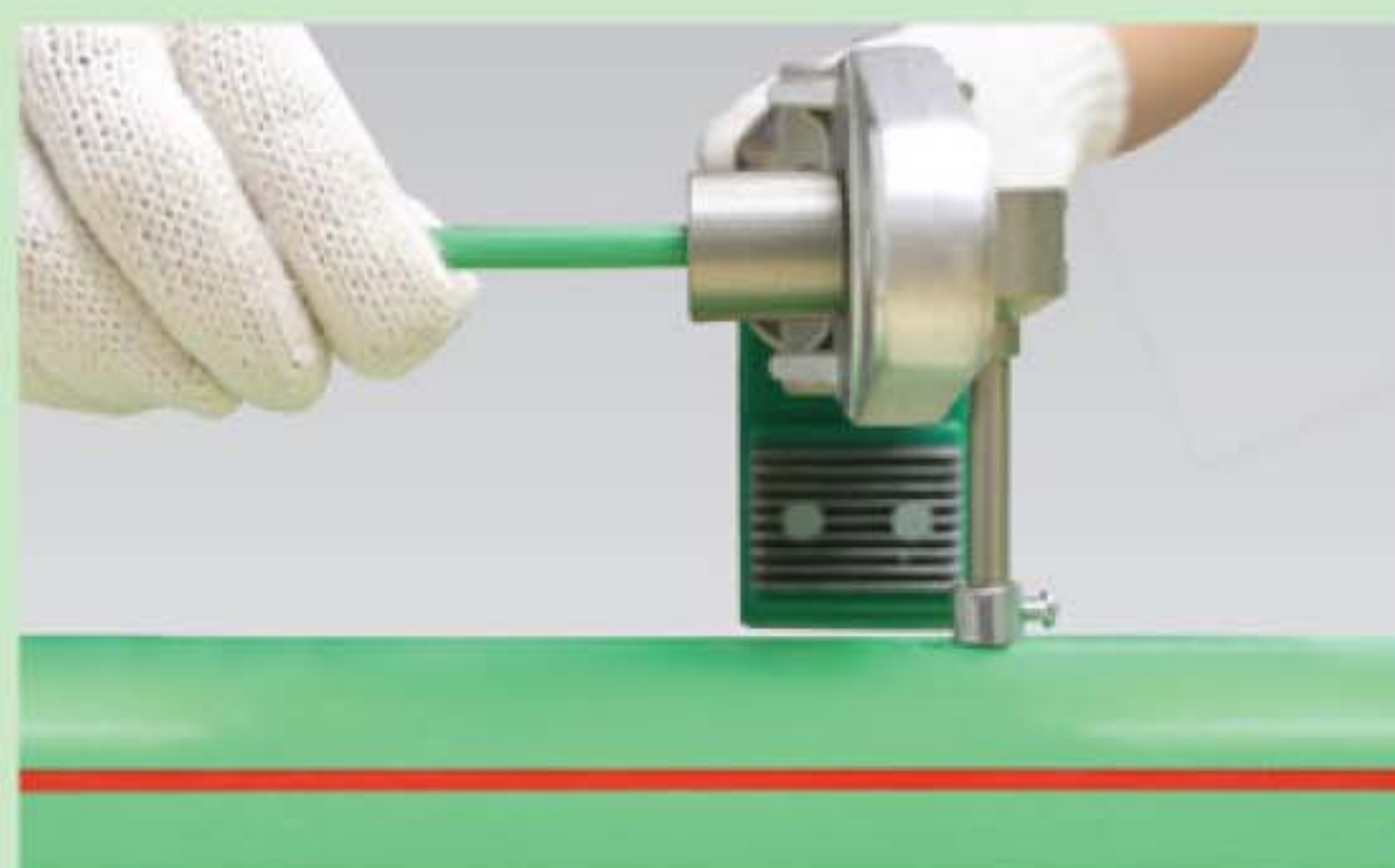
การเชื่อมแท่งซ่อม
